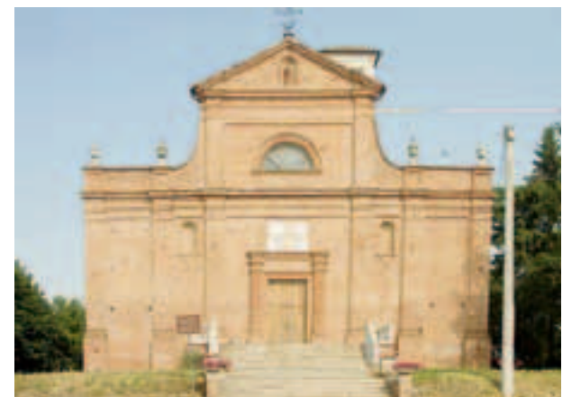
Cuccaro, la chiesa parrocchiale soggetta a restauri
