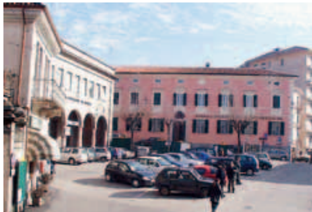
San Salvatore, veduta di piazza Carmagnola prima dei lavori
