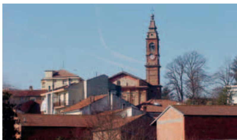
Veduta di Quattordio in paese, molti lavori in programma
