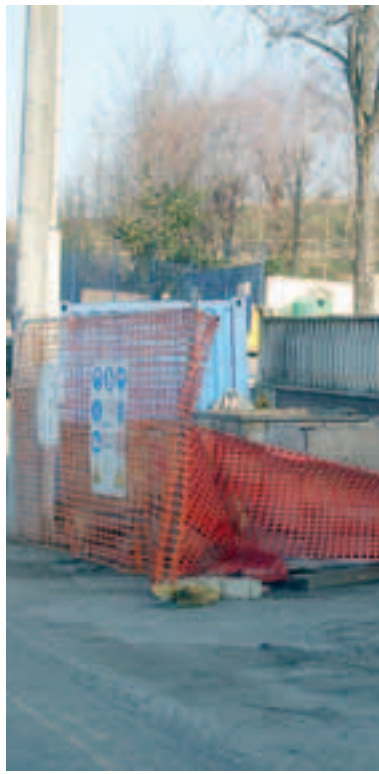
M.B. Cantiere lungo la strada di Vignale
